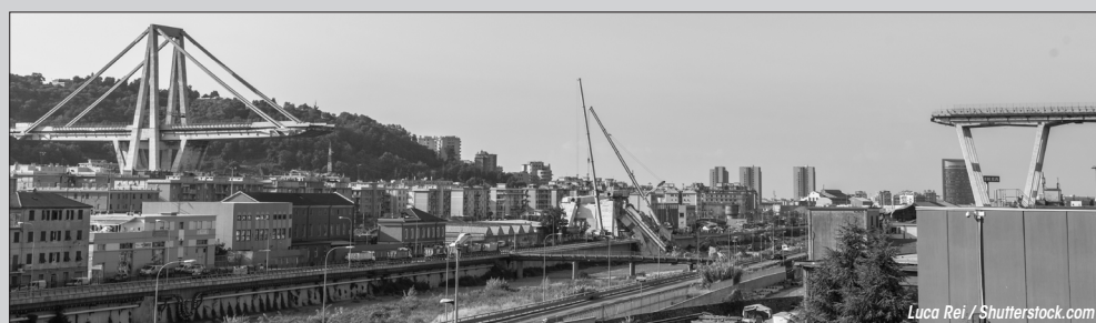
Cosa rimane del crollo del ponte Morandi dopo un cedimento strutturale durante il temporale e le forti piogge del 14 agosto 2018, causando 43 vittime
